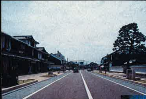
夢京橋キャッスルロード整備中 宗安寺の前から南方向
