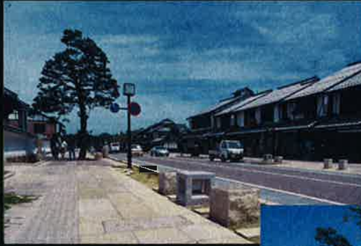
夢京橋キャッスルロード整備中 宗安寺の前から北方向
