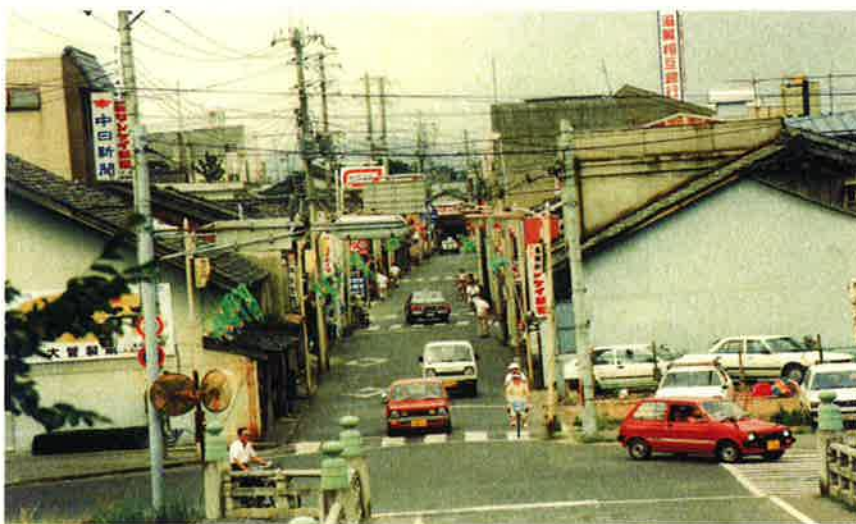
整備前の様子
