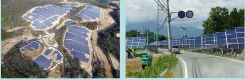
森林を切り開いて設置された太陽光パネル(大分県杵築市) 道路沿いに立ち並ぶ太陽光パネル(山梨県北杜市)
