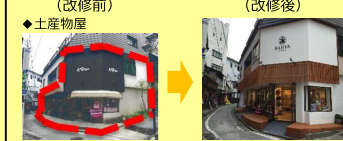
◆土産物屋 (改修前) (改修後)
