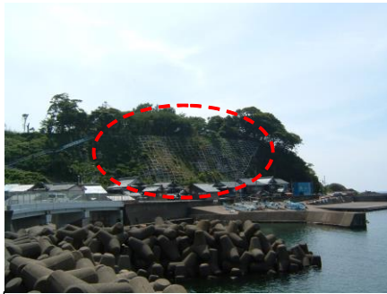
写真5：急傾斜地崩壊対策
