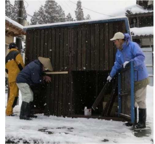
ゴミステーションの板貼り
